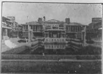
Fachada del nuevo Hotel "Imperial"
